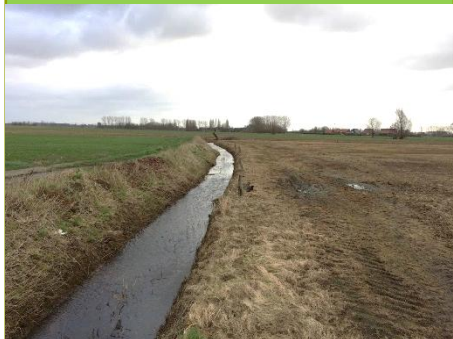
Schade aan oppervlaktewater
